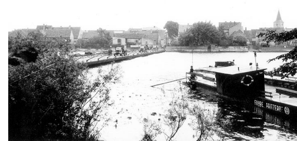
Pontonbrücke über die Havel
